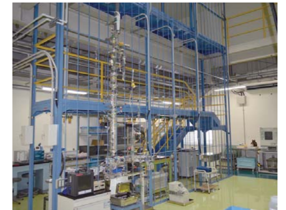
化学工学実験集約設備
